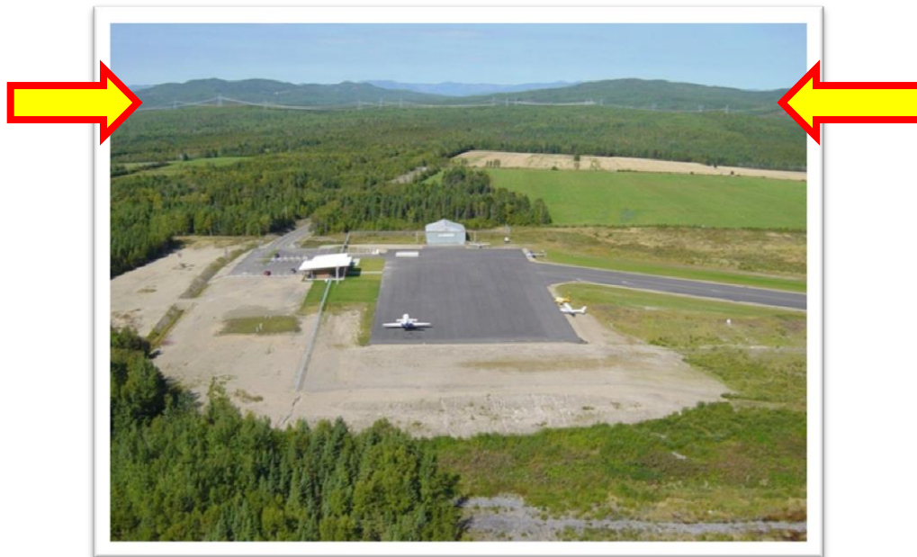
Photo 7.1 Vue des trois lignes à haute-tension d'Hydro-Québec
