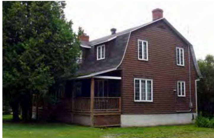
3.54. Résidence construite à partir du modèle n° 2, sise au 103, rue Maisonneuve. Vue de la façade donnant sur la rivière Malbaie.
