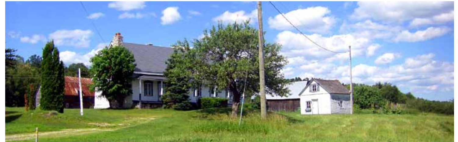
6.39. Le bâti-type de la zone agricole ( unité de paysage 1.4 ), comme en témoigne cette maison de ferme entourée d'une grange-étable, d'un hangar et d'un fournil.
