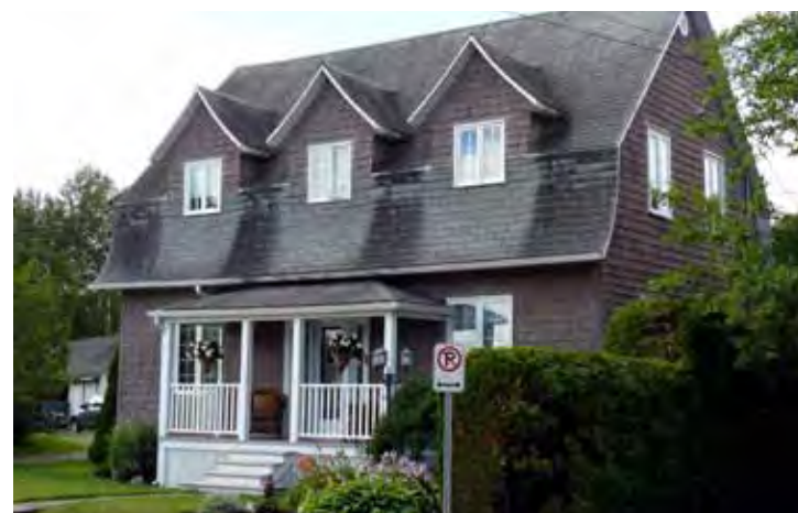
3.48. Résidence construite à partir du modèle « C », sise au 28, rue Maisonneuve.
