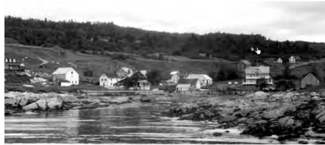
2.19. Vue du hameau de Port-au-Persil à partir du quai, en 1957. Source : © BAnQ.
