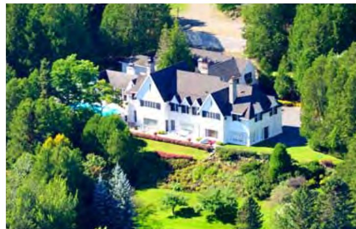
7.69. Villa Les Capucines, sise au 640, chemin des Falaises. Source : © Pierre Lahoud, 2013.
