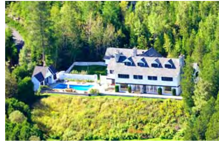
7.70. Villa Aux Quatre Temps, sise au 660, chemin des Falaises, 2013. Source : © Pierre Lahoud, 2013.
