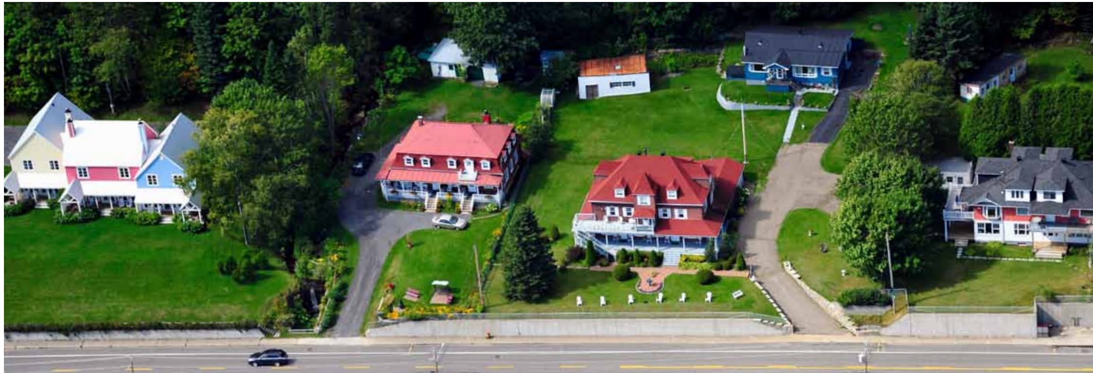
6.32. Implantation du bâti dans la zone de villégiature du chemin des Bains ( unité de paysage 2.1 – La zone de villégiature ). Source : © Pierre Lahoud, 2013.
