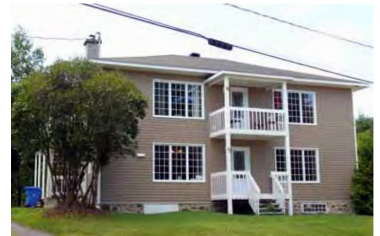
3.35. Maison de J. Bergeron, sise au 92, rue Maisonneuve, telle que visible en 2013.
