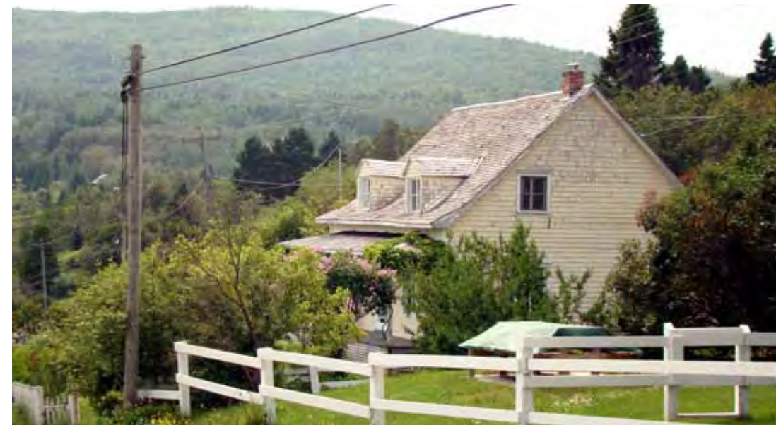
2.24. Bâti type le long du parcours-mère.
