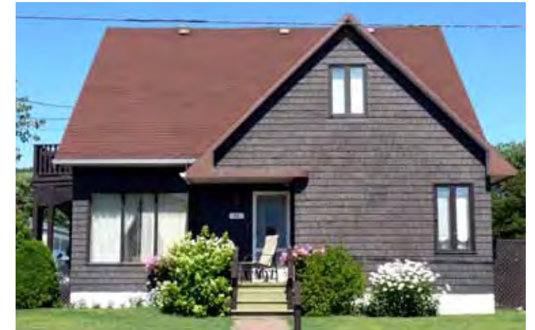
3.59. Maison sise au 61, rue Saint-Philippe, qui reprend quelques caractéristiques des maisons de compagnie.
