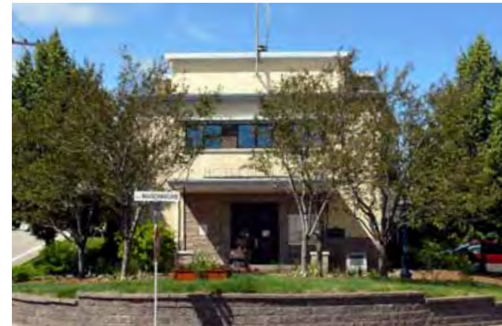
3.39. L'hôtel de ville de Clermont, localisé sur l'ancien terrain de « l'école jaune », à la jonction des rues Lapointe et Maisonneuve.
