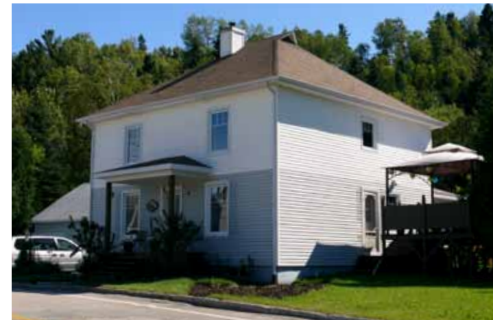
3.33. Résidence sise au 148, rue Lapointe.
