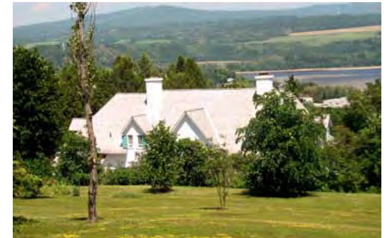
7.43. Villa Les Hirondelles, sise au 113, chemin des Falaises.
