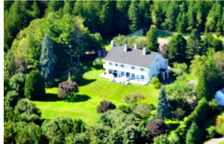
7.68. Villa La Sandraye, sise au 620, chemin des Falaises. Source : © Pierre Lahoud, 2013.
