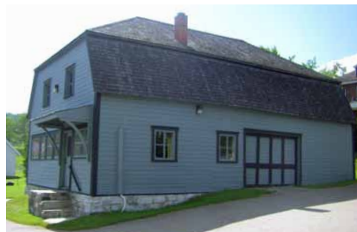
6.54. L'atelier de menuiserie, sis au 290, rue Principale.
