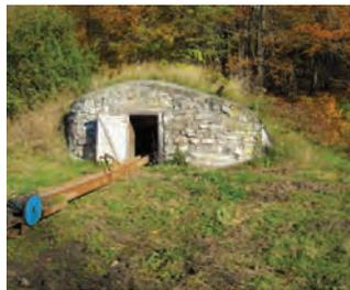
Généralement semi-enterré dans un terrain en pente, le caveau est une construction en maçonnerie permettant de conserver les légumes ou d'autres denrées bien au frais.
