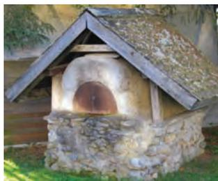
Lorsqu'il est construit à l'extérieur de la maison ou du fournil, le four à pain est en terre ou en brique et il est protégé par un toit en bois.
