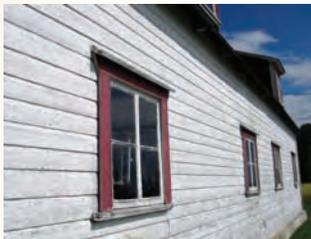
La **planche à feuillure**, ou à gorge, est une planche posée à l'horizontale qui comporte une entaille concave (gorge) permettant d'emboîter les pièces les unes dans les autres. Parfaitement verticales, les planches sont néanmoins protégées contre l'érosion.
