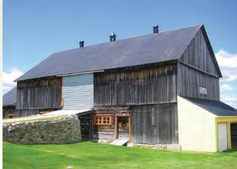
La fermeture de la grande porte de cette grange-étable avec de la tôle est une intervention réversible. Changer les portes et les fenêtres, remplacer les revêtements des murs et de la toiture, réaliser des travaux de peinture et des réparations mineures sont d'autres interventions réversibles.
