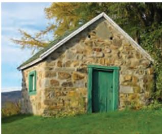
La laiterie, qui sert à garder le lait au frais, est une construction massive en pierre ou en bois pièce sur pièce. Dépourvue de fenêtres, elle est souvent implantée à l'ombre d'un autre bâtiment pour conserver un maximum de fraîcheur.
