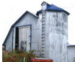
Le silo est destiné à entreposer du fourrage ou du grain. À l'origine, il s'agissait d'une construction en bois; il n'en reste que deux exemples à Baie-Saint-Paul. Les silos plus récents sont construits en béton ou en acier.
