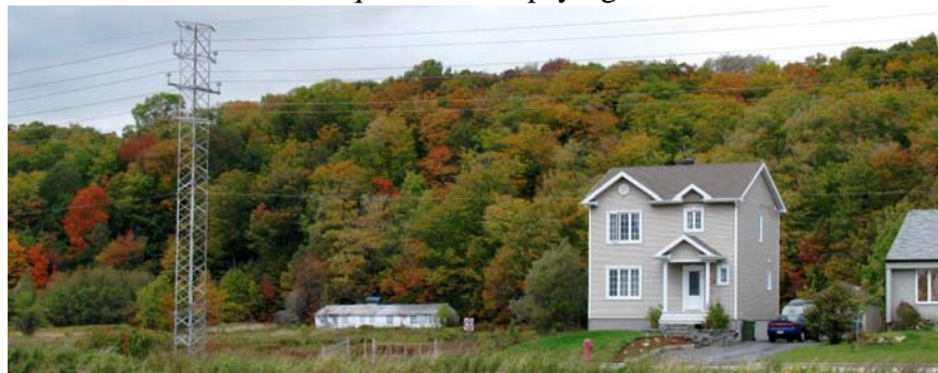
Figure 96. Le long du boulevard Sainte-Anne urbanisé, une maison récente construite sur un ancien lot agricole côtoie un bungalow moins récent, un petit patrimoine, près duquel se retrouve un pylône de transport d'énergie (C3009_001)
