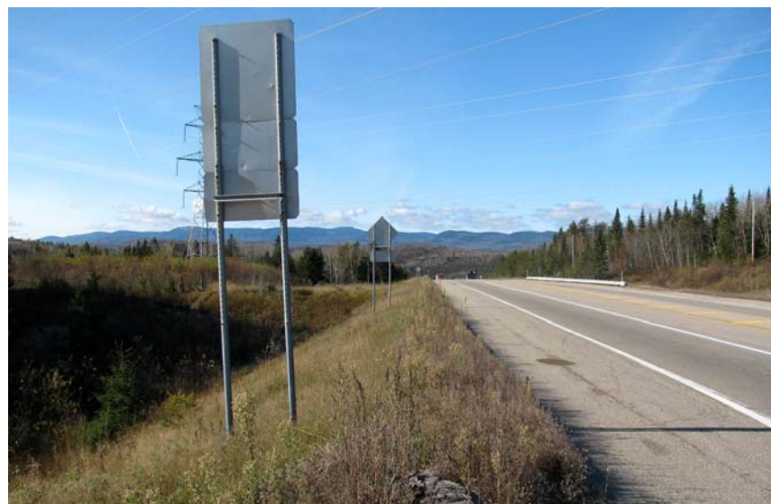
Figure 103. Les friches, les pylônes et l'emprise de la route contribuent à diminuer la qualité paysagère de ce tronçon de la 138, mais il offre quand même une vue sur le contrefort des Laurentides en arrière-plan; entités Le-Mur-des-Laurentides/Côte-à-Matou (C1610_042)
