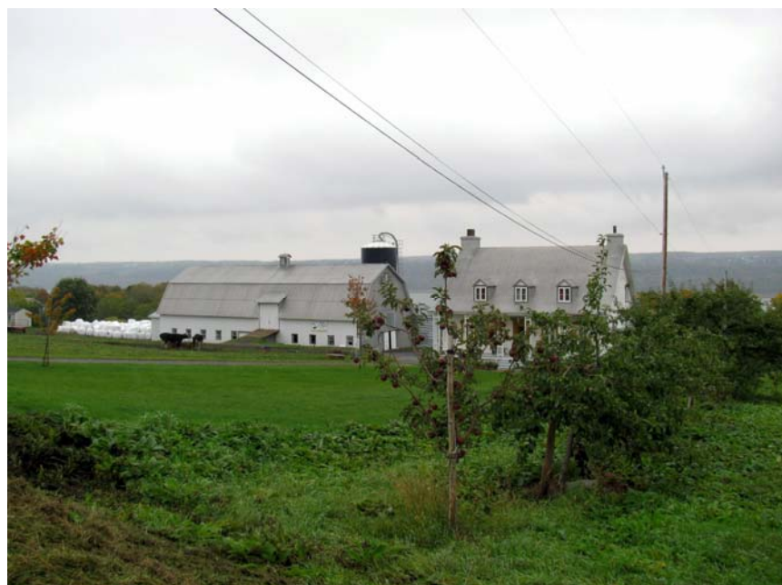
Figure 10. Ferme en exploitation, patrimoine bâti et verger sur l'avenue Royale à L'Ange-Gardien; entité Les-Pylônes (C0210_027)
