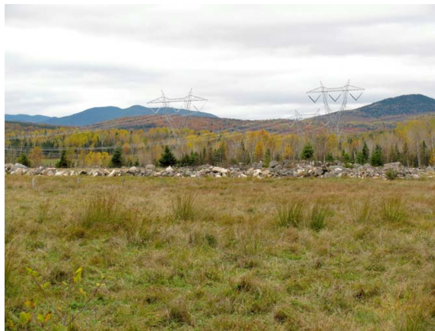
Figure 97. C'est l'absence de zones habitées et l'imposante ligne de pylônes de transport d'énergie qui diminuent la qualité paysagère sur cette route collectrice (rang Saint-Léon/route 360) à Sainte-Tite-des-Caps; entité L'Est-de-Sainte-Tite (C0810_054)
